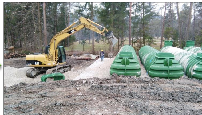
Proces graditve objekta + predaja projektne dokumentacije
