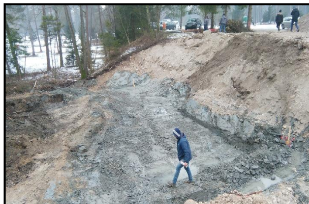
Ogled lokacije gradnje
